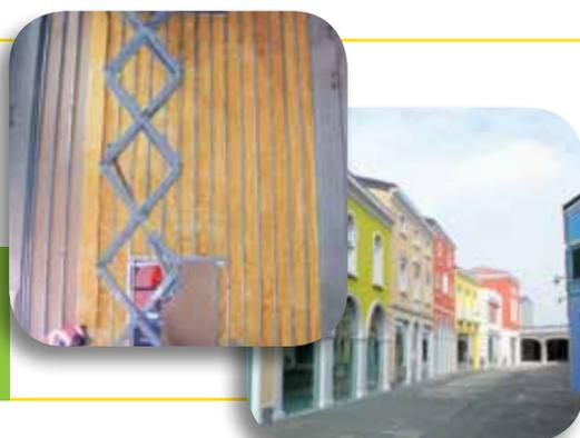
Palmanova Outlet Village è un villaggio dello shopping in provincia di Udine, con oltre 90 negozi. Per realizzare l'isolamento delle pareti divisorie sono stati applicati 12.000 m<sup>2</sup> di PAR G3 touch su pareti alte cinque metri. La possibilità di isolare l'intera altezza della parete posando un solo rotolo di PAR G3 touch ha consentito un notevole risparmio di tempo, un vantaggio particolarmente importante considerata la grande estensione della superficie isolata.
